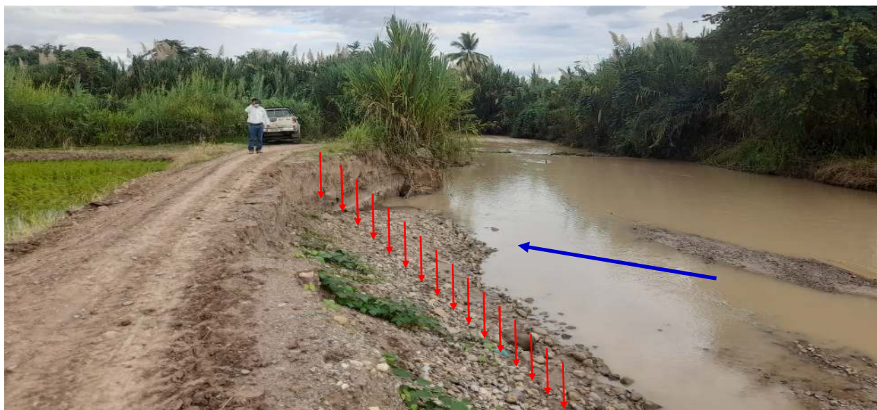
IMAGEN N°03: SE APRECIA LA MARGEN IZQUIERDA EROSIONADA COLINDANTE CON TROCHA CARROZABLE Y LA CAPTACIÓN DEL CANAL SAN CARLOS DE LA COMISION DE USUARIOS COPALLIN
