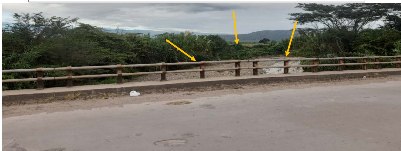
IMAGEN N°02: SE MUESTRA EL MATERIAL SEDIMENTADO AGUAS ABAJO DEL PUNTE ALENYA.
