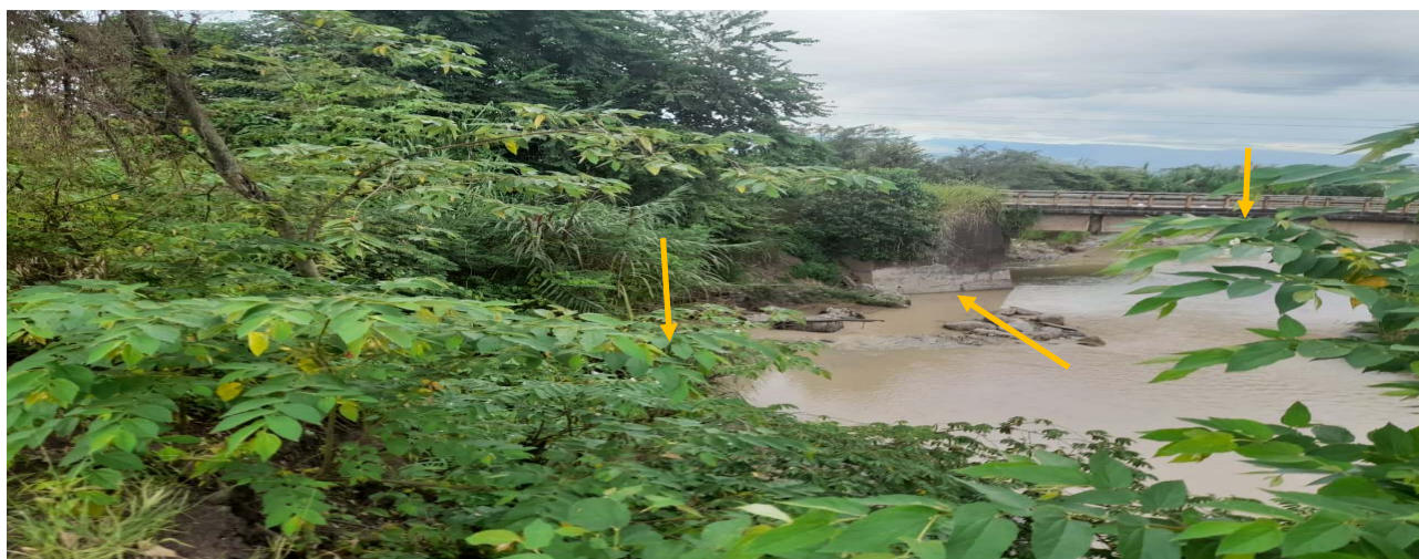
IMAGEN N°01: EL PRIMER TRAMO CRITICO SE APRECIA EL MURO DEL PUNTE ALENYA Y LA ZONA EROSIONADA
